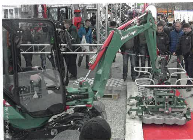
Bauma-Demovorführung: Hunklinger Mini-Mobilbagger HW18 mit Pflasterzange.
